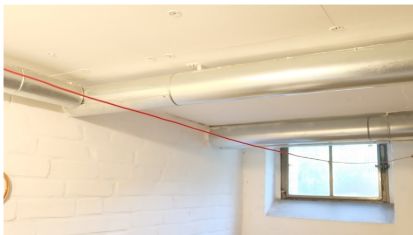
Abbildung 94 Dämmung der Kellerdecke von unten in Stöcken, unterseitig Gipsfaser-Bekleidung, Foto: Unverzagt
