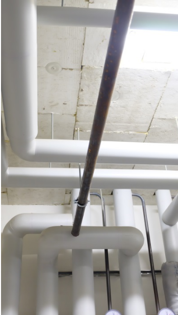
Abbildung 81 Wärmebrückeneffekt am Abweig zum Ausdehnungsgefäß: Zur Vermeidung von Wärmeabgabe wäre eine flankierende Dämmung sinnvoll.
