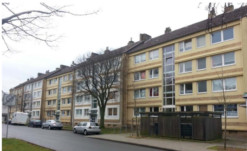
Abbildung 65 Vor der Modernisierung: Hi-E34-42, D2+4
