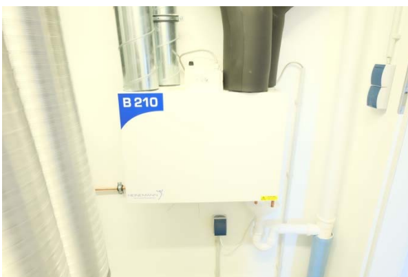
Abbildung 97 Wohnung Hi-E38 mit Lüftungsanlage mit Wärmerückgewinnung. Foto links: Lüftungsgerät in der Dachzentrale, Brandschutzklappen in der Dachzentrale
