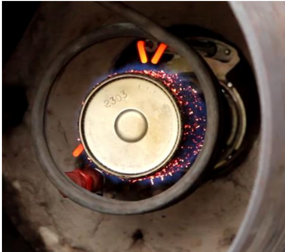
Bild 72: Flammenbild des Oberflächenbrenners im Erdgasbetrieb
