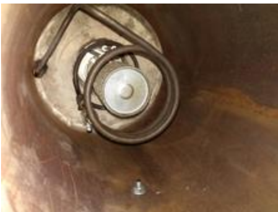
Bild 53: Ansicht der integrierten Verdampferspirale mit Oberflächenbrenner
