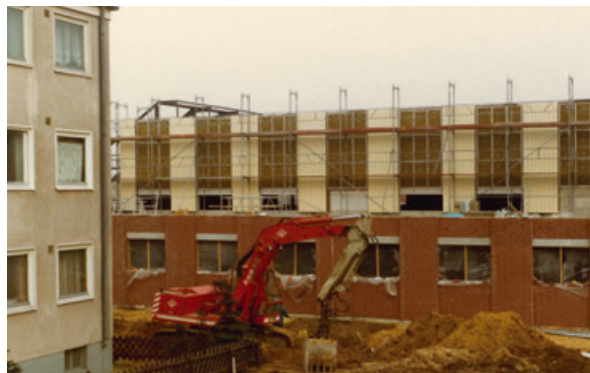
Drei Bilder von links: Gebäude M im Bau
