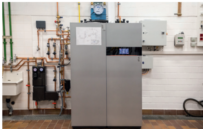
Versuchsstand Brennstoffzellen-Heizgerät (Brennstoffzelle: thermische Leistung: 1,1 kW, elektrische Leistung: 750 W) mit integriertem Spitzenlast-Brennwertgerät mit 11 kW und 200l-Speicher
