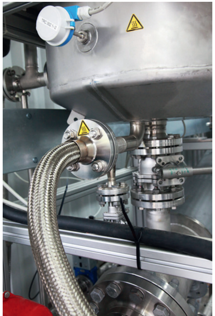
Detailansicht Thermo-Rührkesselreaktor im Pilotmaßstab
