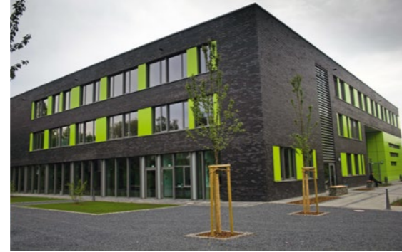
Medien- und Hörsaalzentrum am Campus Salzgitter
