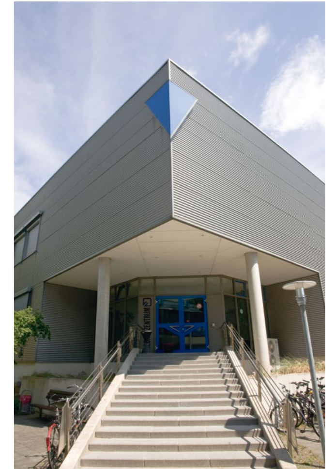
Rechenzentrum am Campus Wolfenbüttel
